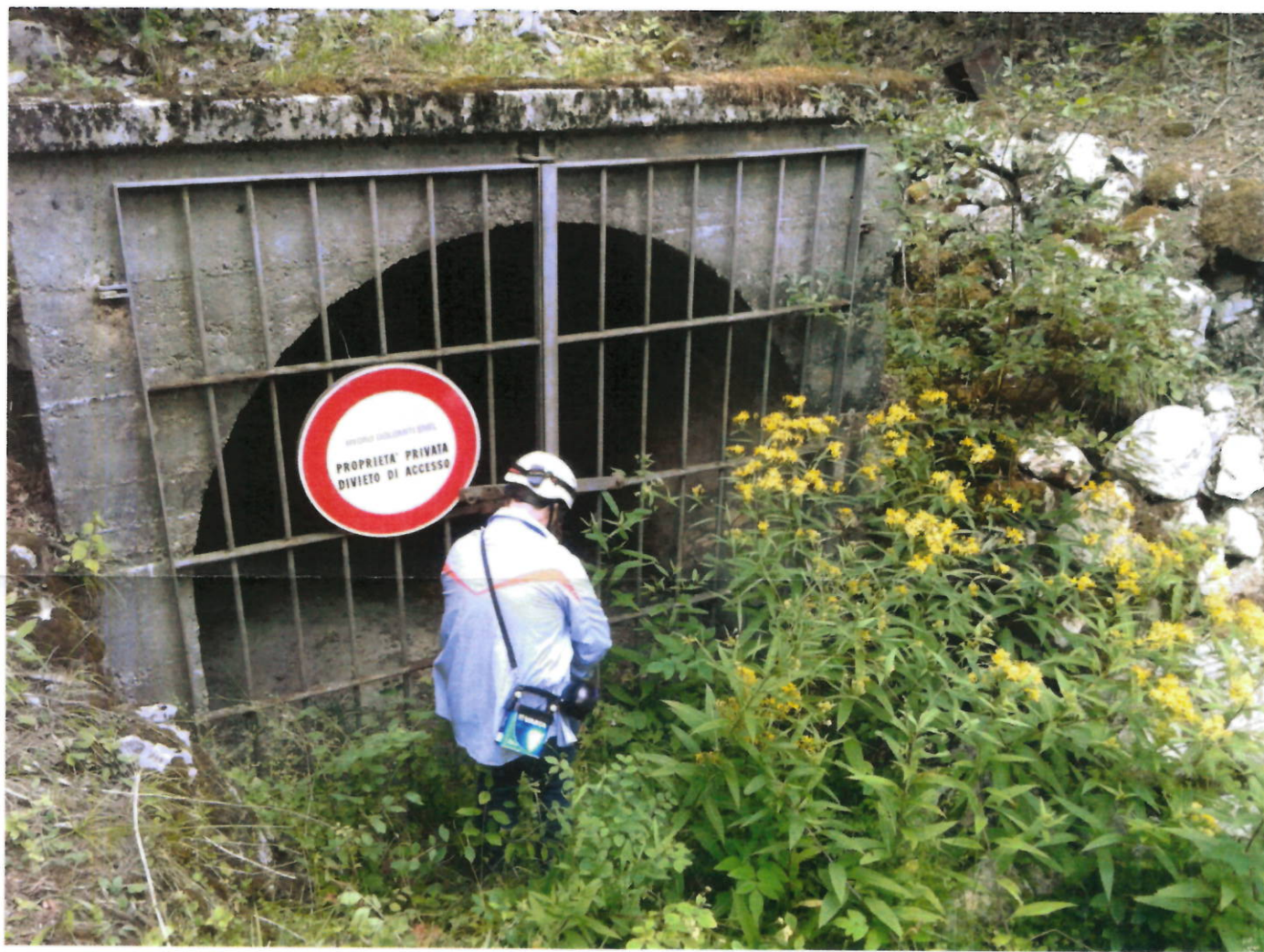
Foto 2: dettaglio imbocco cunicolo in loc. Nembia
