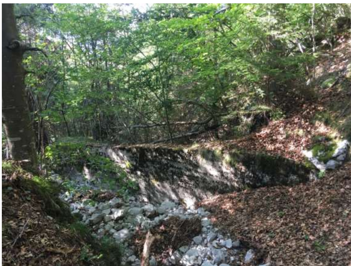
Figura 7.4 Canale secondario a valle del muro deviatore e muro di sbarramento
