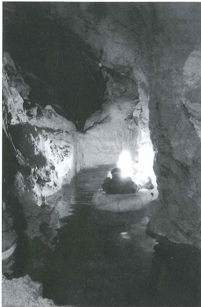
Galleria Ambiez Alto-Nembia. Caverne nel tronco a valle della finestra rimasta allagata in fase di scavo il 17 aprile 1951 poi prosciugatasi alla fine del ciclo nivale primaverile.
