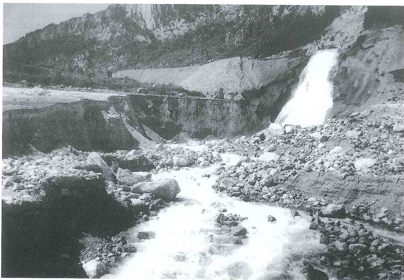
Cantiere di Nembia. Sbocco nel lago di Molveno della portata d'acqua della galleria di gronda a partire dal torrente Arnò in val Breguzzo, ai due torrenti Bedù e Sarca di Rendena e oltre fino ai torrenti Algone e Ambiez nel Gruppo di Brenta.
