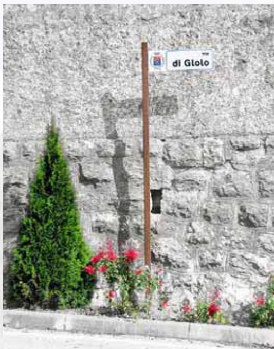
Nuova toponomastica a palina. Palina in acciaio cor-ten e targhetta in alluminio. Foto elemento realizzato e posizionato.
