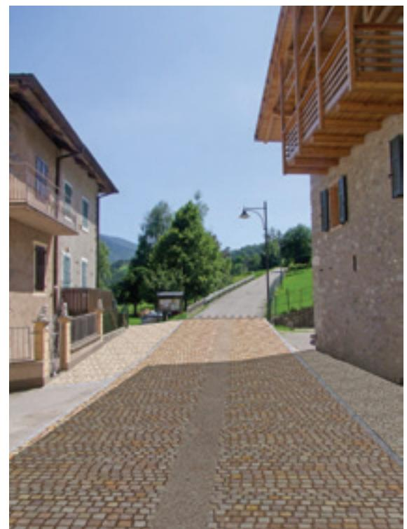
pre a filari diritti e sigillati a resina. Il piano stradale principale è predisposto lungo la direttrice principale e sarà caratterizzato da una pavimentazione in cubetti posati a filari paralleli a corsi sfalsati ed ortogonali con la linea centrale della strada.
