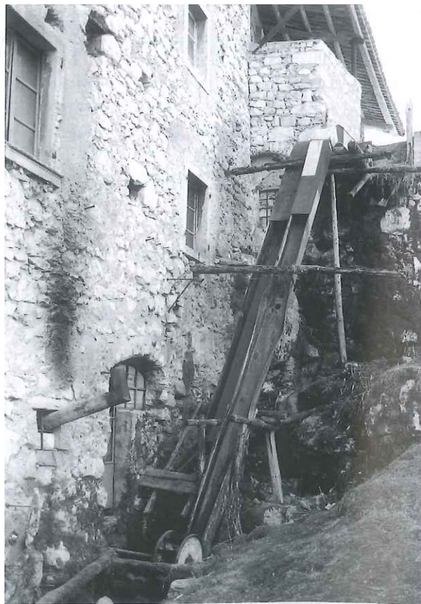
Antiche strutture di convogliamento dell'acqua nella fucina degli Aldrighetti Freri di Moline
