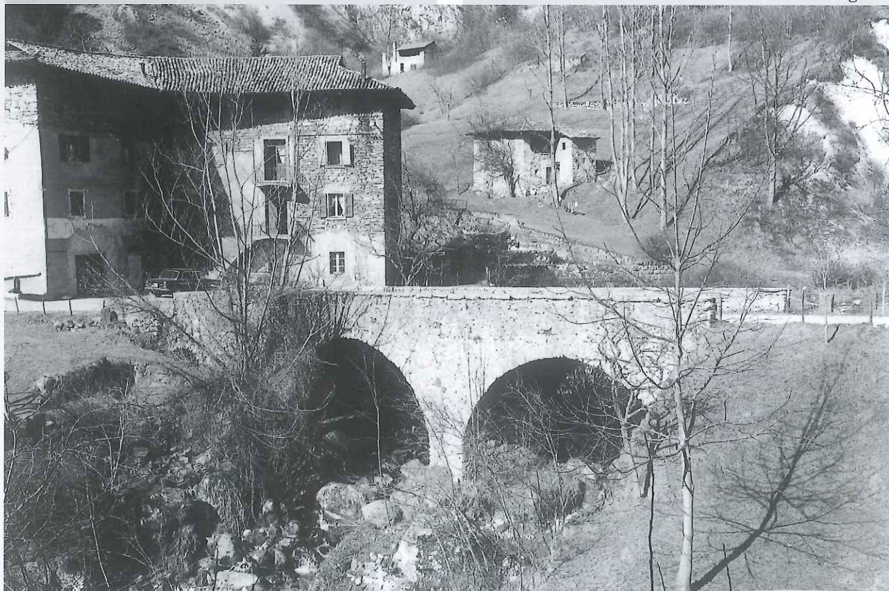
Le arcate del ponte viste da sud-est, case sparse nella valletta lungo il ramo dei Paróí
