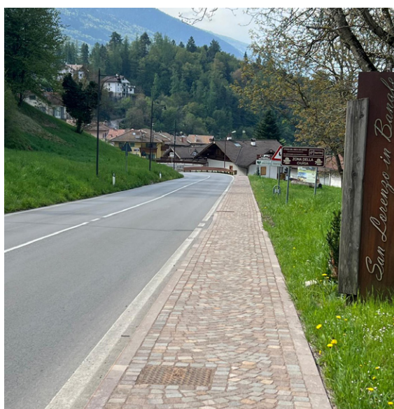
Marciapiede San Lorenzo – Manton
